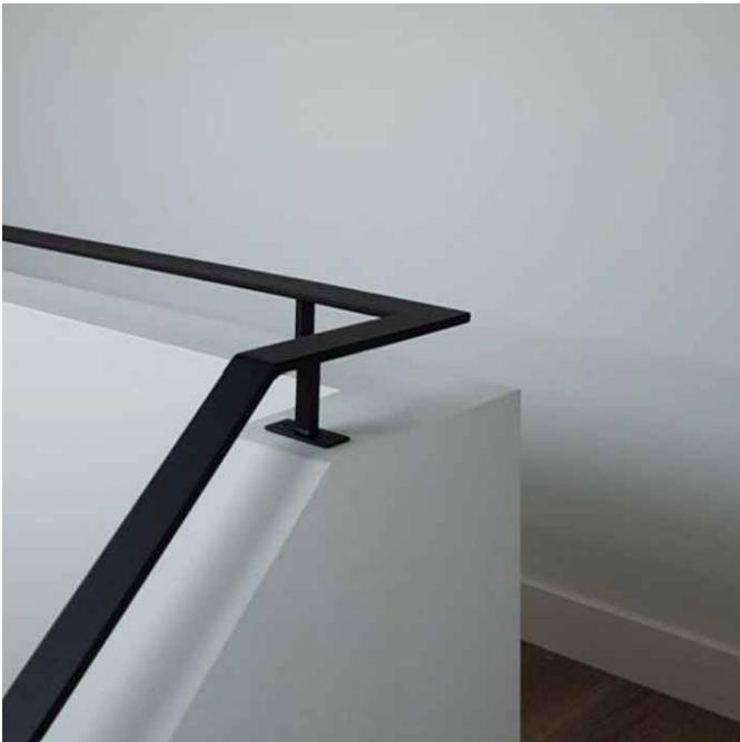
NOVÉ MADLO ZÁBRADLÍ
