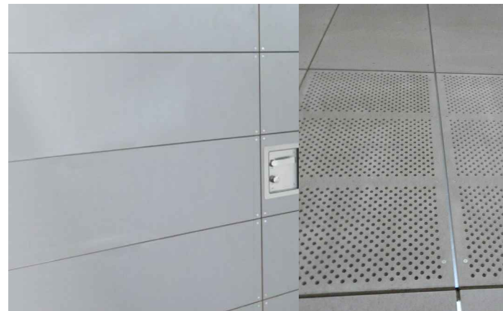
STĚNA U PODIA A PROTILEHLÁ, OBKLAD SLOUPŮ (KOMBINACE S AKUSTICKÝMI PANELY)
